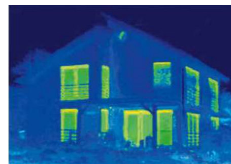
Tras la instalación profesional de nuevas ventanas del sistema Schüco LivIng, la termografía demuestra el alto beneficio energético de la inversión. La pérdida de energía original se elimina casi por completo.
